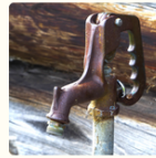
Bomba de agua en un sistema de plomería
