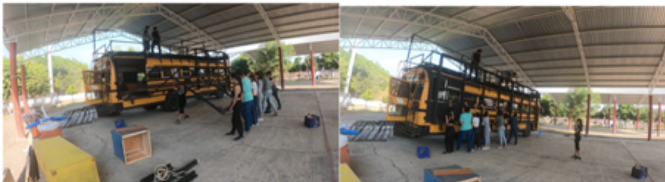
Figura 3. Construcción del escenario para la obra de teatro (13/dic/21)
